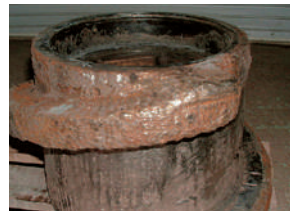
タングステンカーバイド粒子肉盛施工
